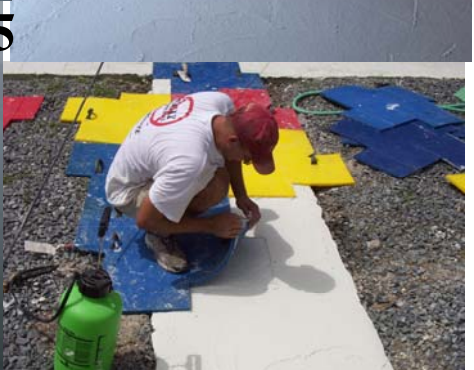
5/ Application des empreintes Remarquez l'empreinte souple ci-dessus pour traiter les remontées sur les murs. Voir également l'utilisation du pulvérisateur pour appliquer le décoffrant liquide avant le travail d'empreinte
