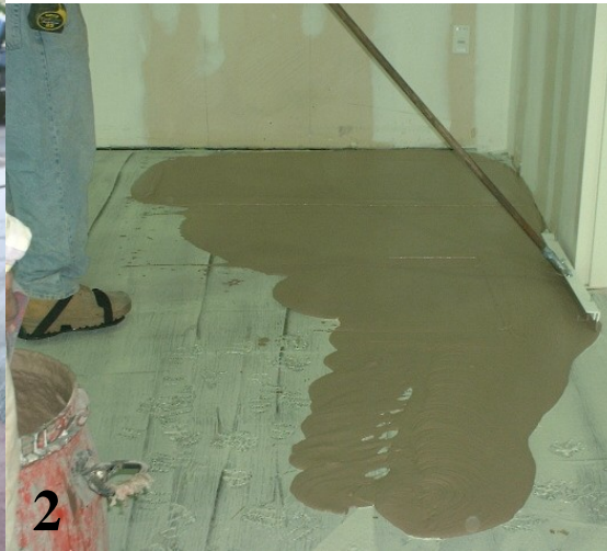
Application d'un béton frais (1) ou d'un mortier (2) spécial Empreinte (Flex-C-Ment) 3/ Lissage
