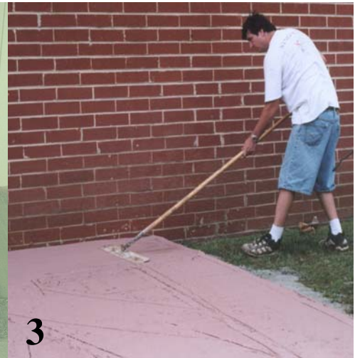
Application d'un béton frais (1) ou d'un mortier (2) spécial Empreinte (Flex-C-Ment) 3/ Lissage
