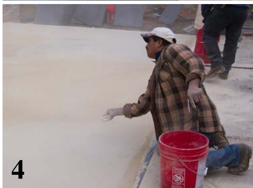
4/ Application d'un durcisseur de surface
