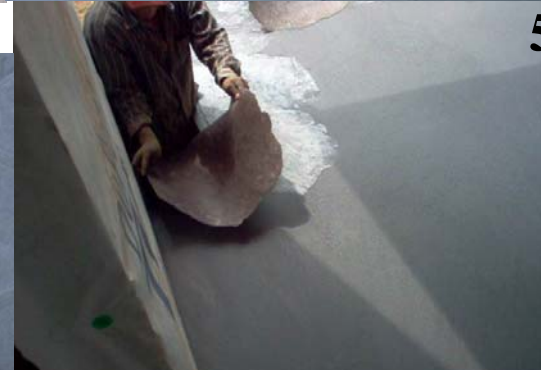
4/ Application d'un durcisseur de surface
