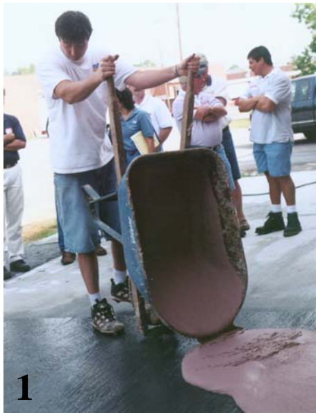
Application d'un béton frais (1) ou d'un mortier (2) spécial Empreinte (Flex-C-Ment) 3/ Lissage
